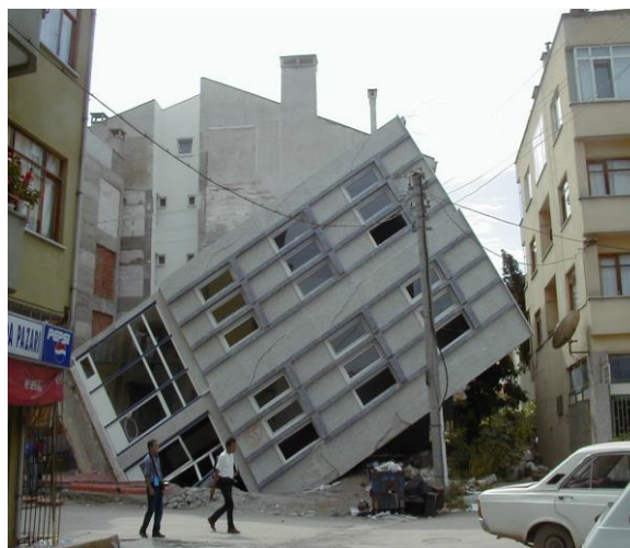
Figure 7 Phénomène induit par les secousses [2]
