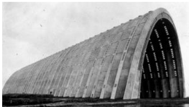
Figure I. 5 Hangar pour dirigeable, Voûte en arc
