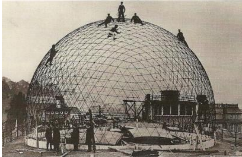
Figure I. 3 Ossature en treillis 3-D du prototype du planétarium, 1922
