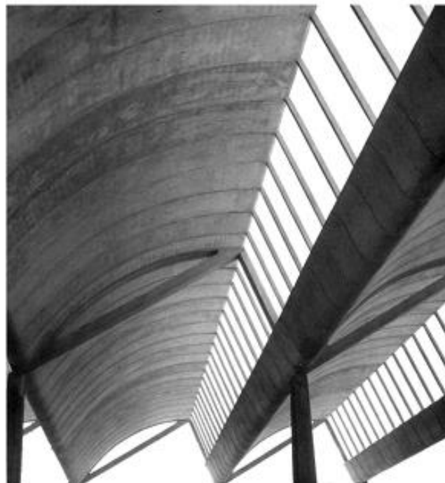
Figure I. 16 Coque cylindrique en shed
