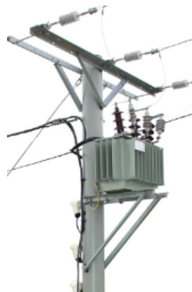
FIGURE I.5 – Poste MT/BT sur poteau [7]
