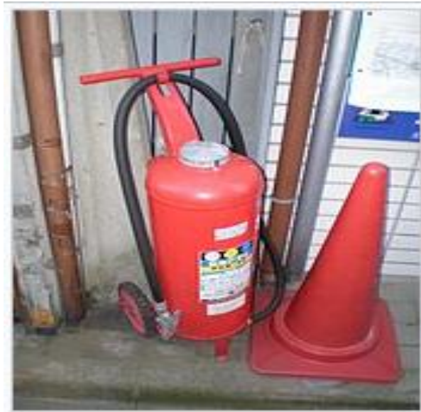
Figurell.5. Image d'extincteur sur roue de 50kg à poudre[Wikipédia].
