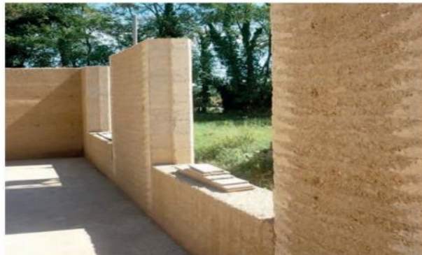
Figure I:1. Construction en pisé
