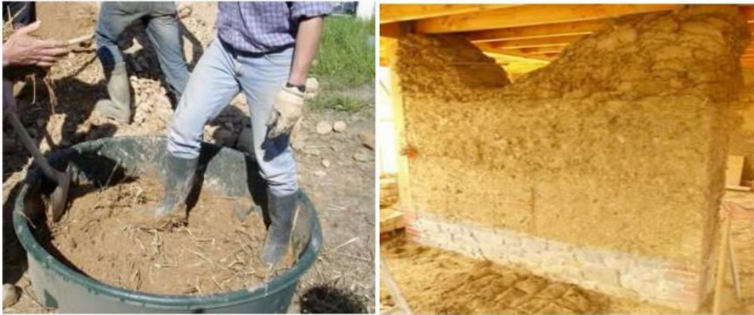
Figure I.3. Construction d'un mur en bauge
