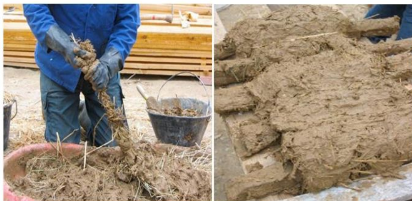
Figure I:4. Préparation de torchis
