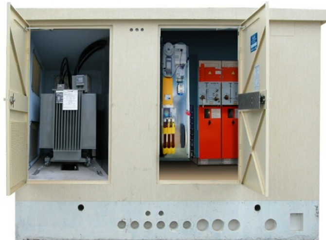
Figure 1.10 : Illustration d'un poste de transformation HTA/BT [8]
