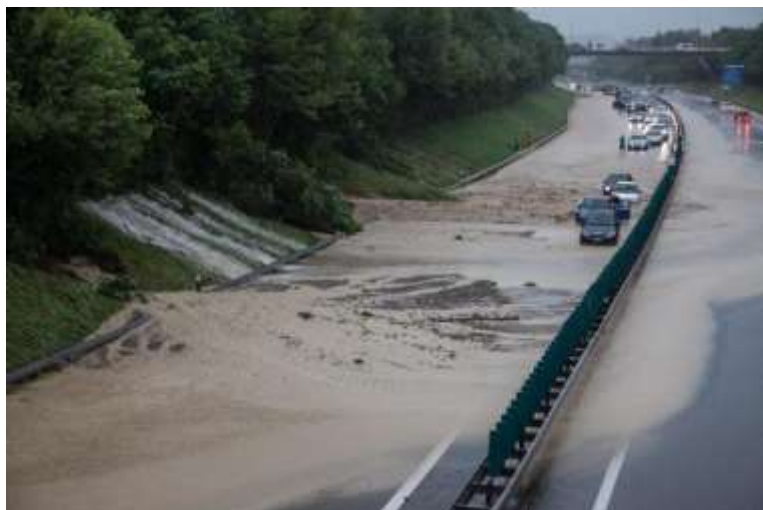
Figure I.7. Inondation routière en Suisse Romande [6]
