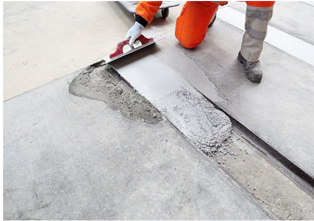
Figure 1. 12 : Réparation d'une chaussée par du béton polymère.
