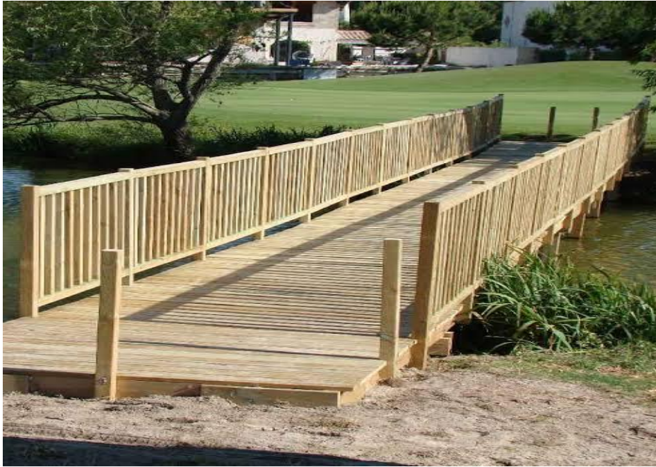
Figure 1-2: Photo illustrant une passerelle
