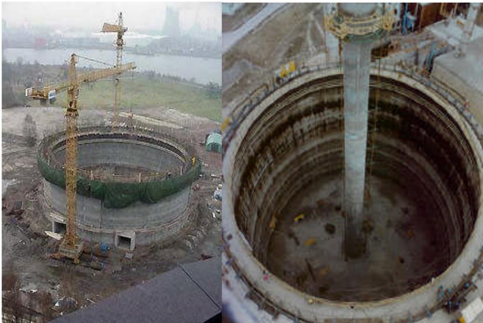
Figure 9: Chantier d'exécution d'un silo [12]
