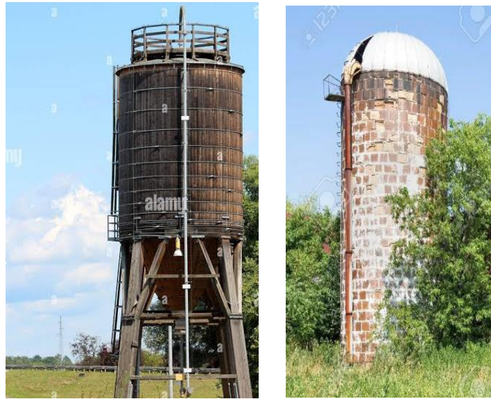
Figure 4 : silo en bois (à gauche) et silo en maçonnerie (à droite) [13], [14]
