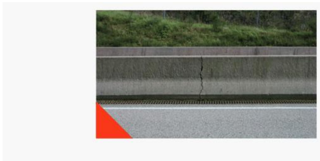
Figure 11. Maîtrise des effets du retrait par fractionnement [31].
