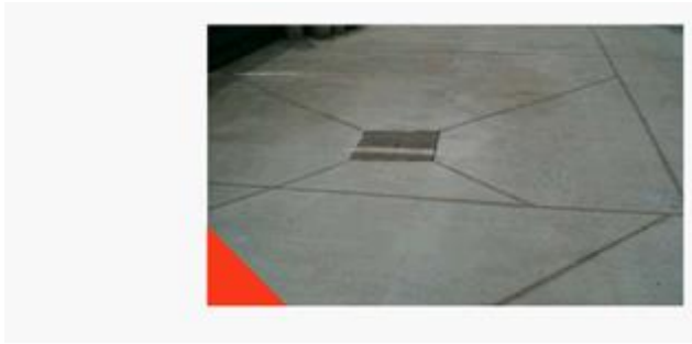
Figure 11. Maîtrise des effets du retrait par fractionnement [31].
