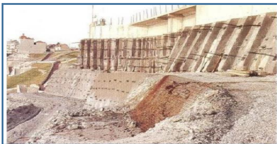
Figure 1.16. Illustration de tirants d'ancrage actif (Hakima DAHMANI, 2013)
