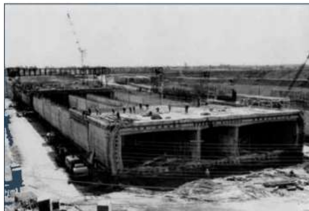
Figure 1-3 : Construction en voie d'achèvement d'un caisson en préfabriqué
