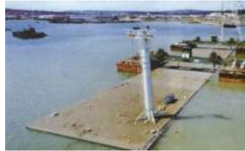
Figure 1-13 : Mise ne place du caisson de tunnel. [9]
