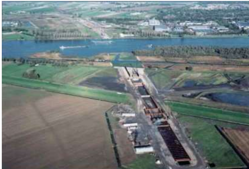
Figure 1-5 : Vue sur le Tunnel Immergé de Thalys aux Pays Bas
