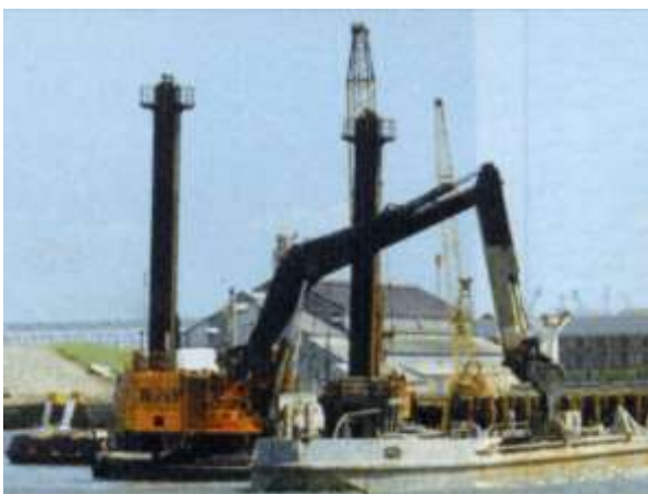
Figure 1-11 : Opération de dragage. [9]
