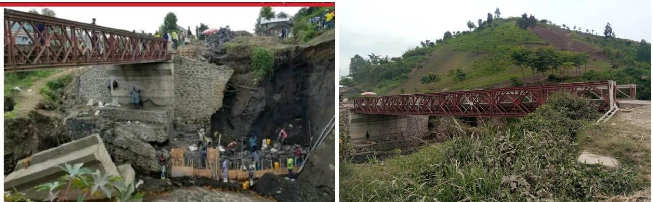
Figure 1.2 Situation géographique de l'ouvrage
