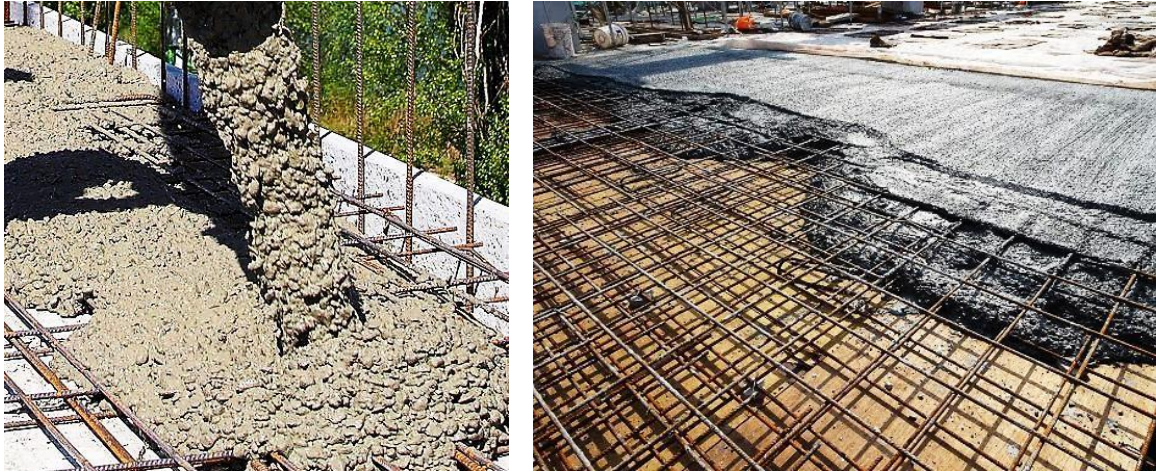
Figure 1-1 Le béton armé [11]
