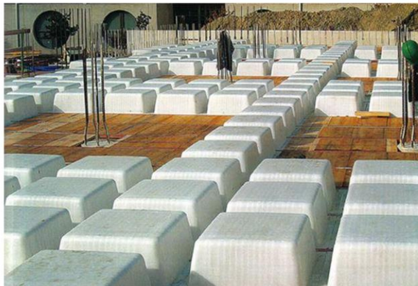
Figure 2-12: Caissons récupérables à proximité des poteaux
