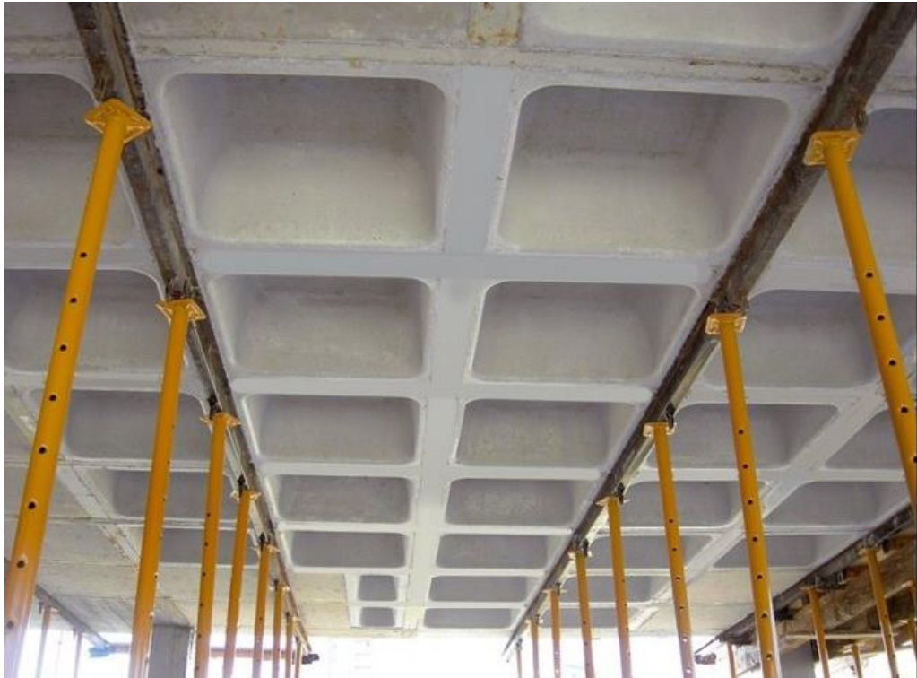
Figure 1-9: Dalles Réticulées à Caissons Récupérables
