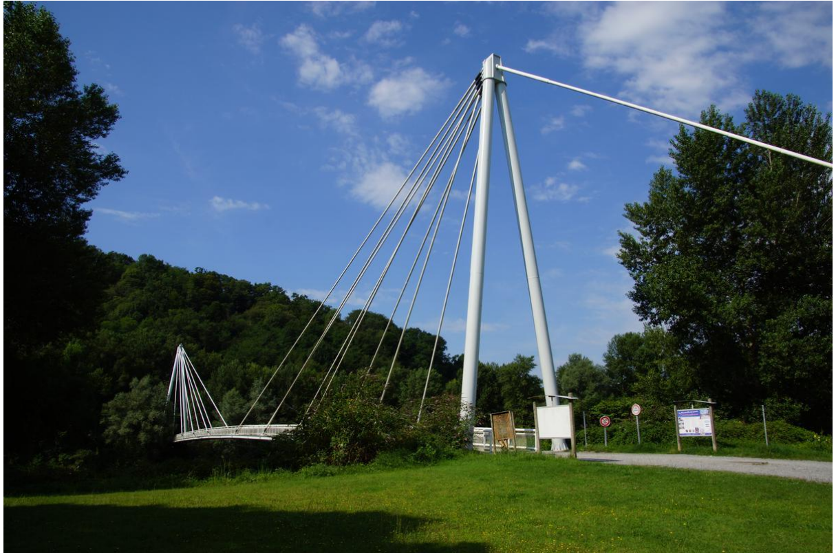
Figure 1-7: Passerelle haubanée de Laroin-France
