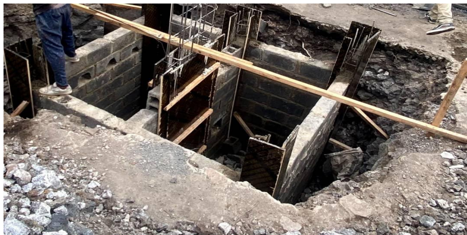
Figure8 fosse septique à Goma
