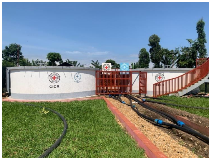
Figure 2.4 : Nouveaux réservoirs de COMEPO
