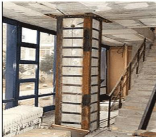
Figure 1-7 Chemisage en acier d'un poteau [1]
