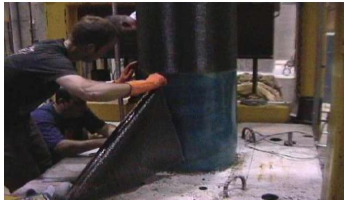
Figure 1-8 Chemisage en fibre d'un poteau
