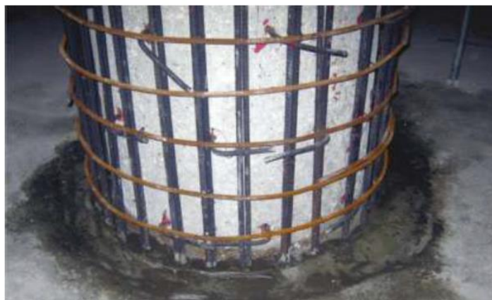
Figure 1-6 Chemisage d'un poteau
