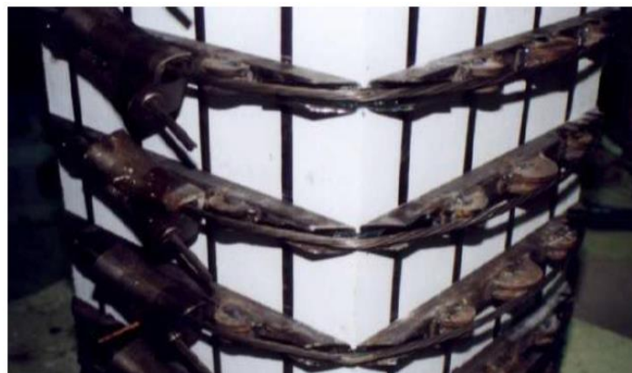
Figure 1-9 Renforcement d'un poteau carre par précontrainte externe.
