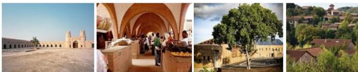
Figure I. 5 Exemples récents de constructions en terre. De gauche à droite : le Fort d'Al Jahili, Al Ain à Abou Dhabi aux Emirats arabes unis créé en 1891 et restauré en 2008 ; le marché de Koudougou au Burkina-Faso construite en blocs de terre comprimée au début
