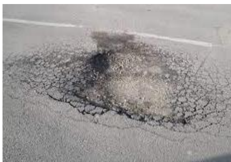
Figure 1.16 : Exemple d'un nid de poule sur une chaussée [5]
