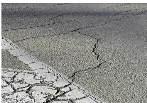
Figure 1.15 : Exemple des fissures diverses sur une chaussée [5]
