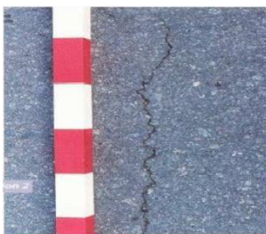
Figure 1.12 : Exemple d'une fissure transversale [5]
