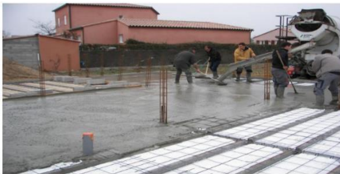
Figure 1.15: coulage du béton de la table de Compression
