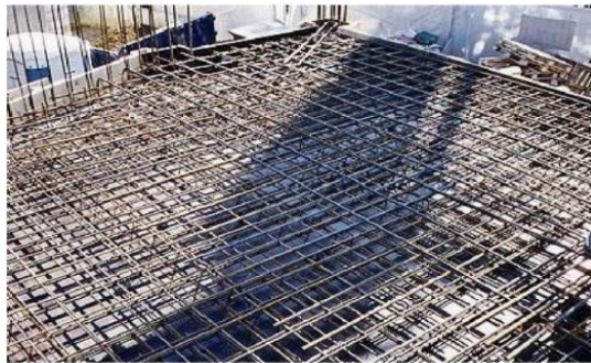
Figure 1.6: ferrailage d'une dalle pleine
