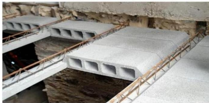
Figure 1.13 : mise en place des entrevous
