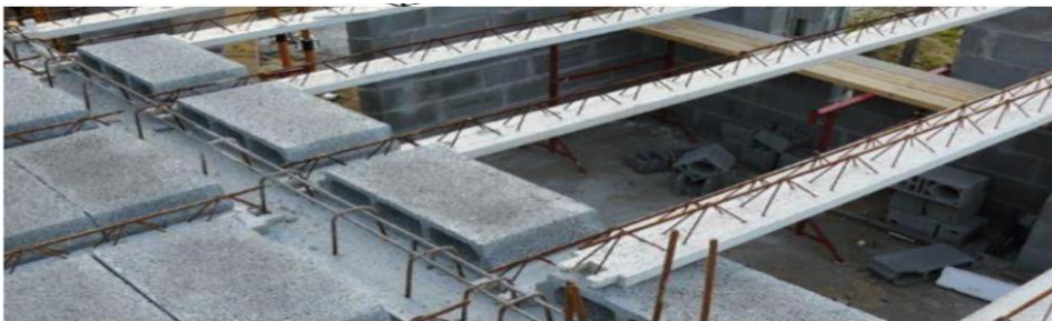
Figure 1.11: mise en place de poutrelles
