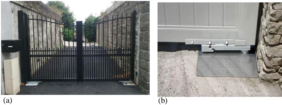
Figure 1.9 : motorisation enterrée [4]
