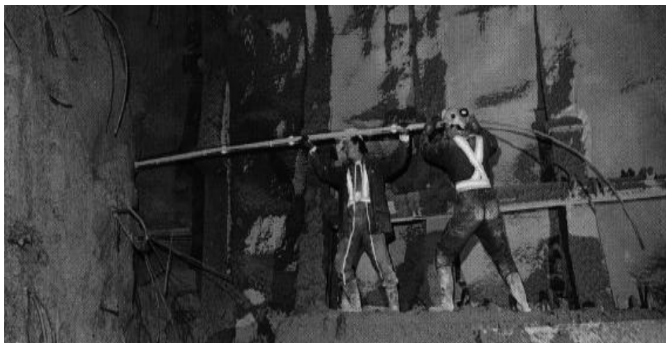
Figure X.2.2. Pose des boulons en fibre de verre au Front de taille
