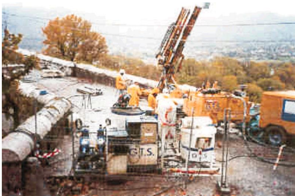
Figure X.2. Atelier de forage et centrale d'injection
